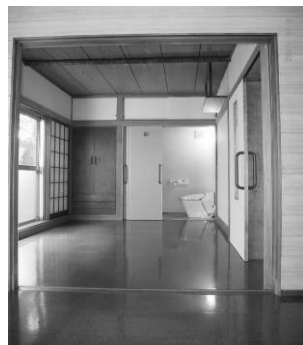
改修後押入を 専用トイレへ
