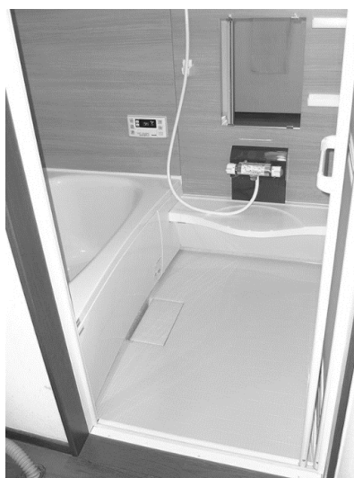
ユニットバスに改修
