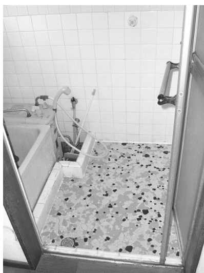
改修前の浴室
