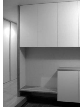
新築や改修時に造り 付けベンチを設置
