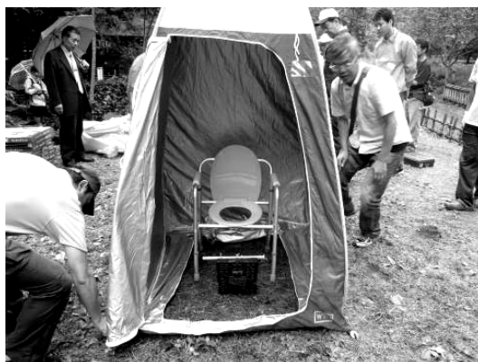
マンホールトイレにテントを設置したところ
