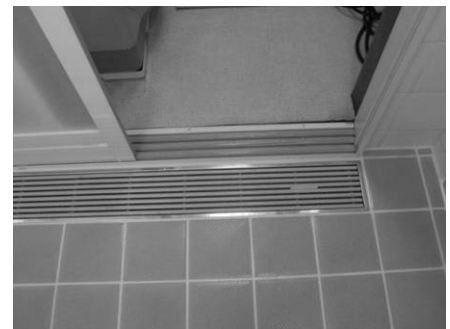
段差なしでグレーチングを設置
