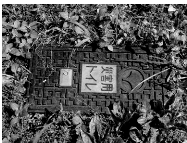
マンホールトイレが30箇所設置されていました。
